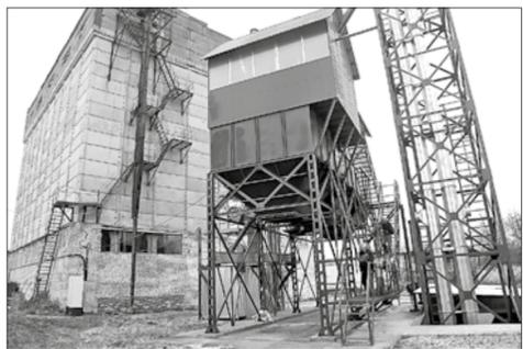
▲ Элеватор рассчитан на обработку 100 тонн зерна в час при сортировке и 20 тонн в час при сушке.
