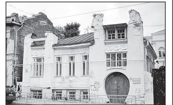
Реконструкция будет вестись под контролем
