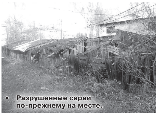
Разрушенные сараи по-прежнему на месте.
