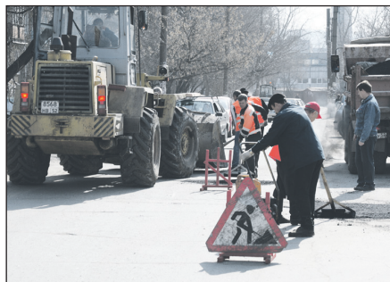
Работы идут полным ходом
