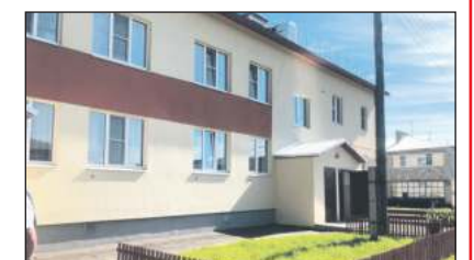
На строительство новых домов потратили около 55 млн рублей
