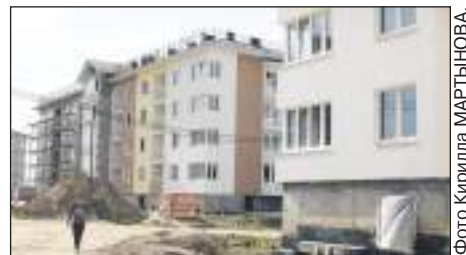
Строительство ЖК «Новинки Smart City» не прекращается
