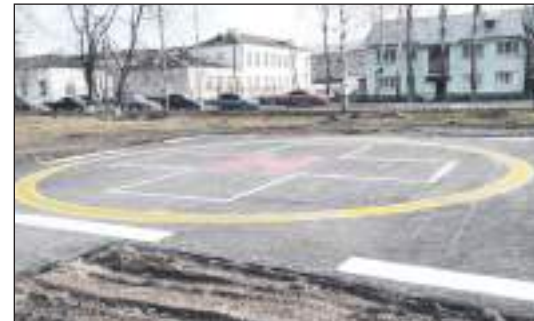
Осталось установить светосигнальное оборудование
