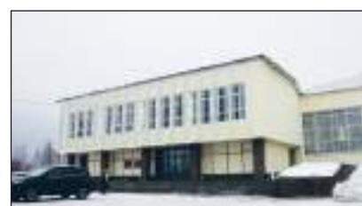
Сам Дом культуры тоже недавно отремонтировали
